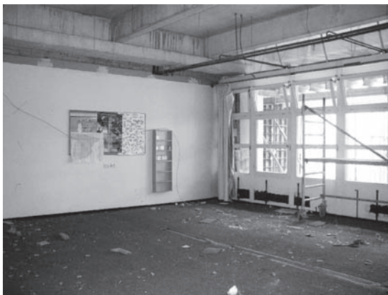
Die neue Mensa vor dem Innenausbau
